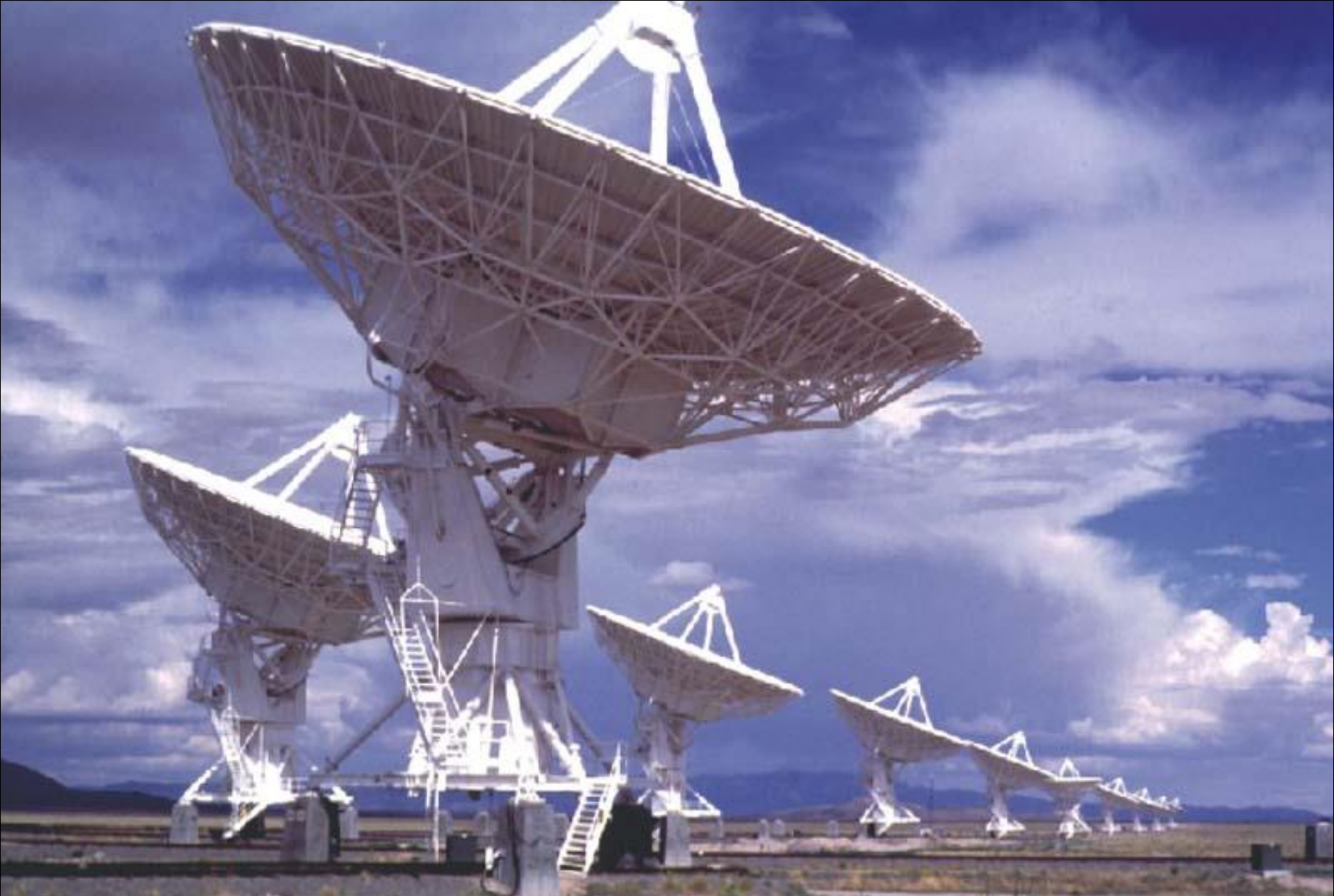
VLA - 27 антенн диаметром 25 м, 3 плеча (Y) по 22,4 км
