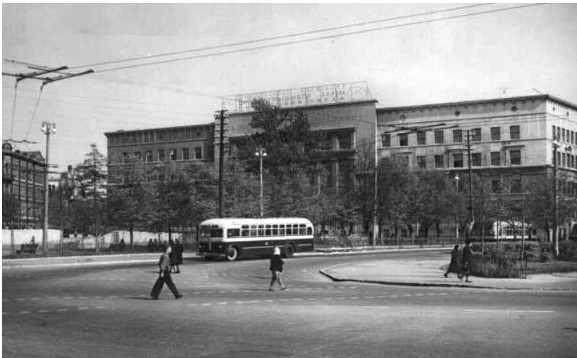
Здание Пединститута, где располагалось ГАГО и обсерватория
