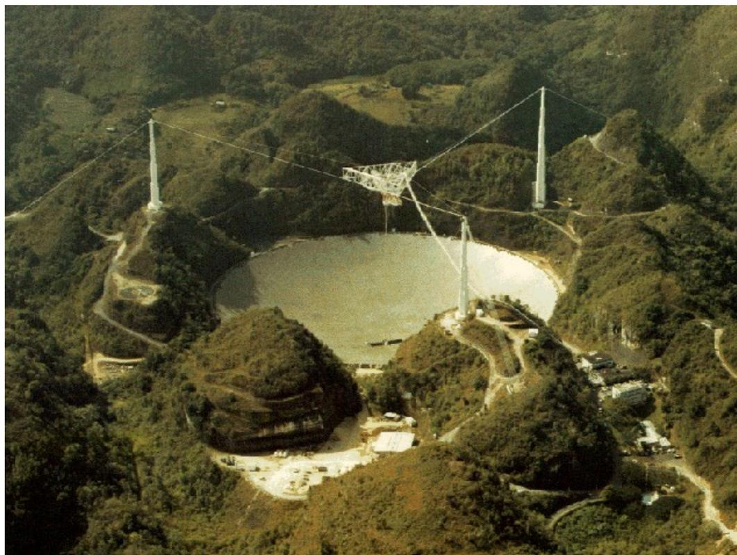
Радиотелескоп + планетный радар 0.5 МВт
