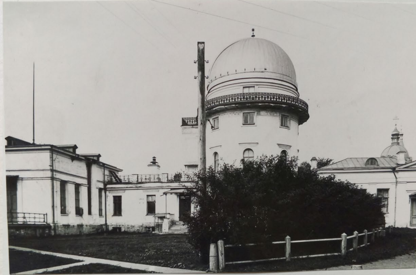
МОСКОВСКАЯ ОБСЕРВАТОРИЯ ПОСЛЕ ПЕРЕСТРОЙКИ
