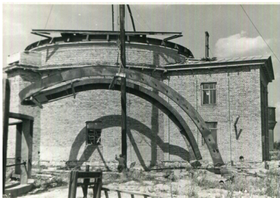
Рис. 11. Монтаж купола башни 26-дюймового рефрактора. 1953 г.
